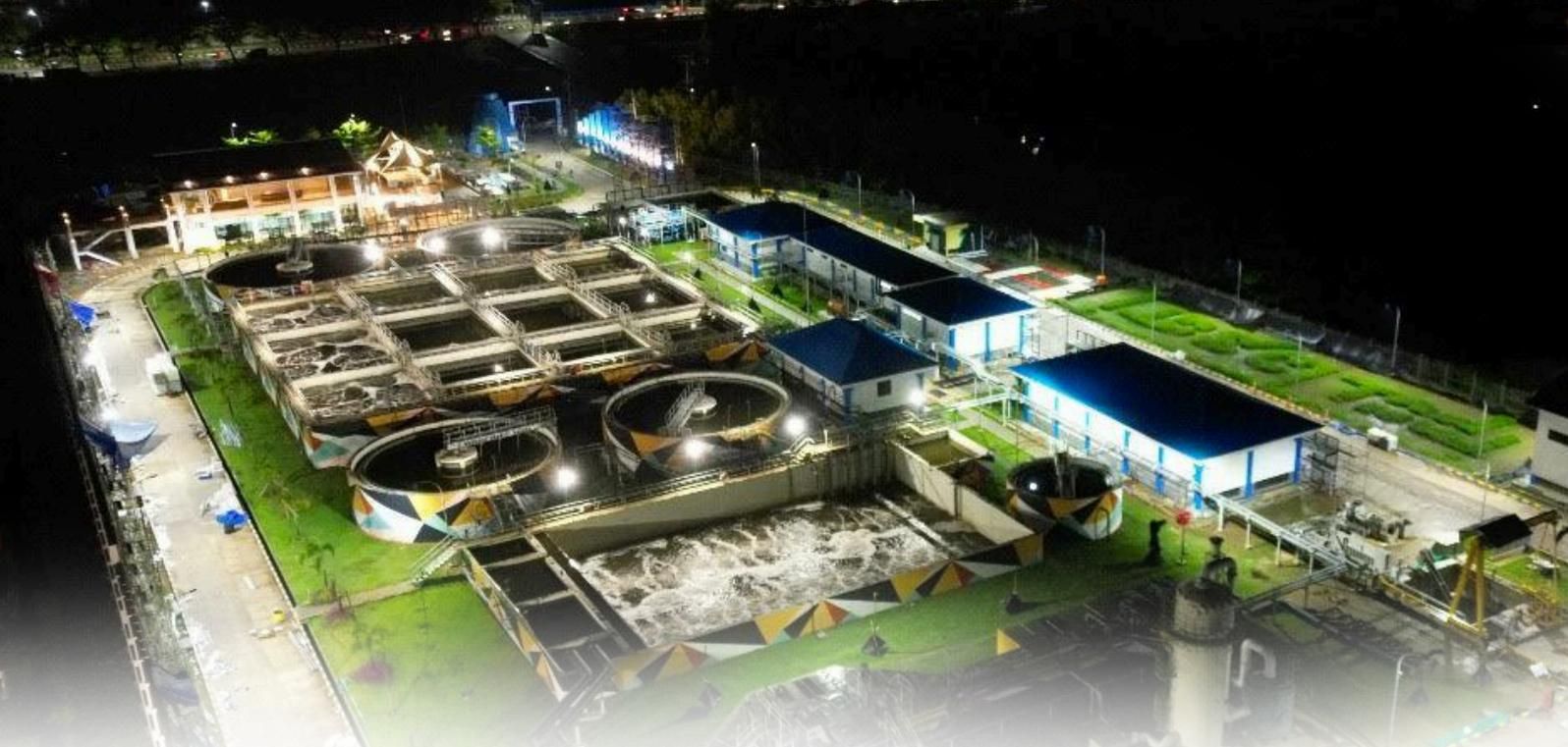
SPALD-T Losari dibangun sebagai sistem pembuangan limbah terpusat. Pembangunan SPALD-T Losari menelan total biaya 1.217 T menggunakan sistem mutakhir yaitu *Moving Bed Biofilm Reactor* (MBBR). Teknologi MBBR mereduksi *Biological Oxygen Demand* hingga 95 persen, denitrifikasi dan mengurangi nitrogen sehingga efluen yang dihasilkan dapat memenuhi baku mutu air limbah domestik.
