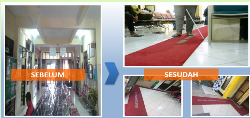
Akses bagi penyandang disabilitas di dalam ruangan Puskesmas Janti
