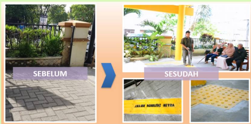
Akses bagi penyandang disabilitas di luar ruangan Puskesmas Janti
