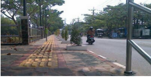
Fasilitas trotoar dengan guiding block untuk penyandang disabilitas.
