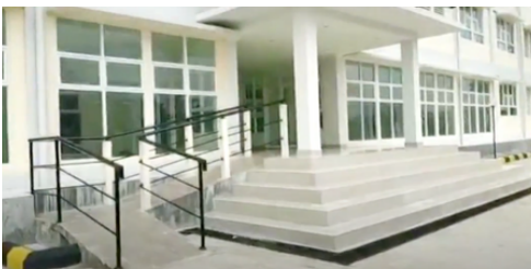
Fasilitas hand rail dan jalur kursi roda di rusun Teluk Kelayan
